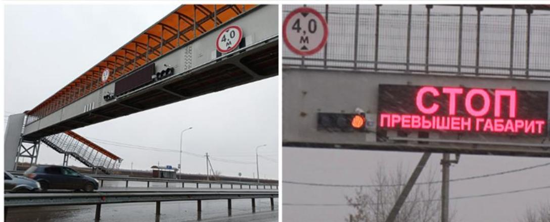
За 300 метров от надземного пешеходного перехода установлены лазерные датчики, выявляющие грузовые транспортные средства, непроходящие по габаритам мостовых сооружений и тоннелей.
