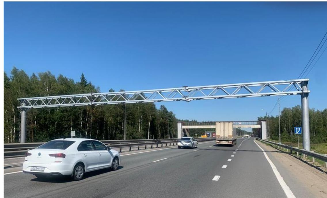
Габаритные ворота, расположенные у модульного надземного пешеходного перехода на км 85+287 автомобильной дороги М-7 «Волга»
