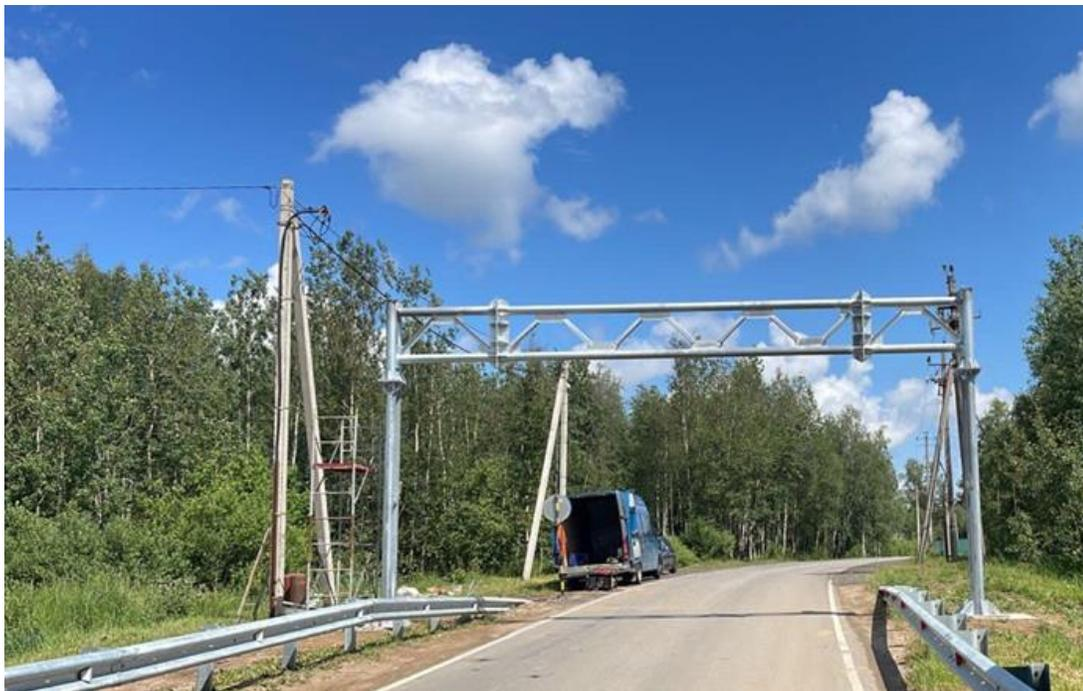
Габаритные ворота, расположенные у путепровода на км 59+152 (правый) автомобильной дороги М-9 «Балтия»
