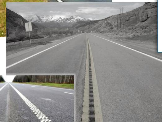
линии разметки 1.3 со структурной или профильной поверхностью
